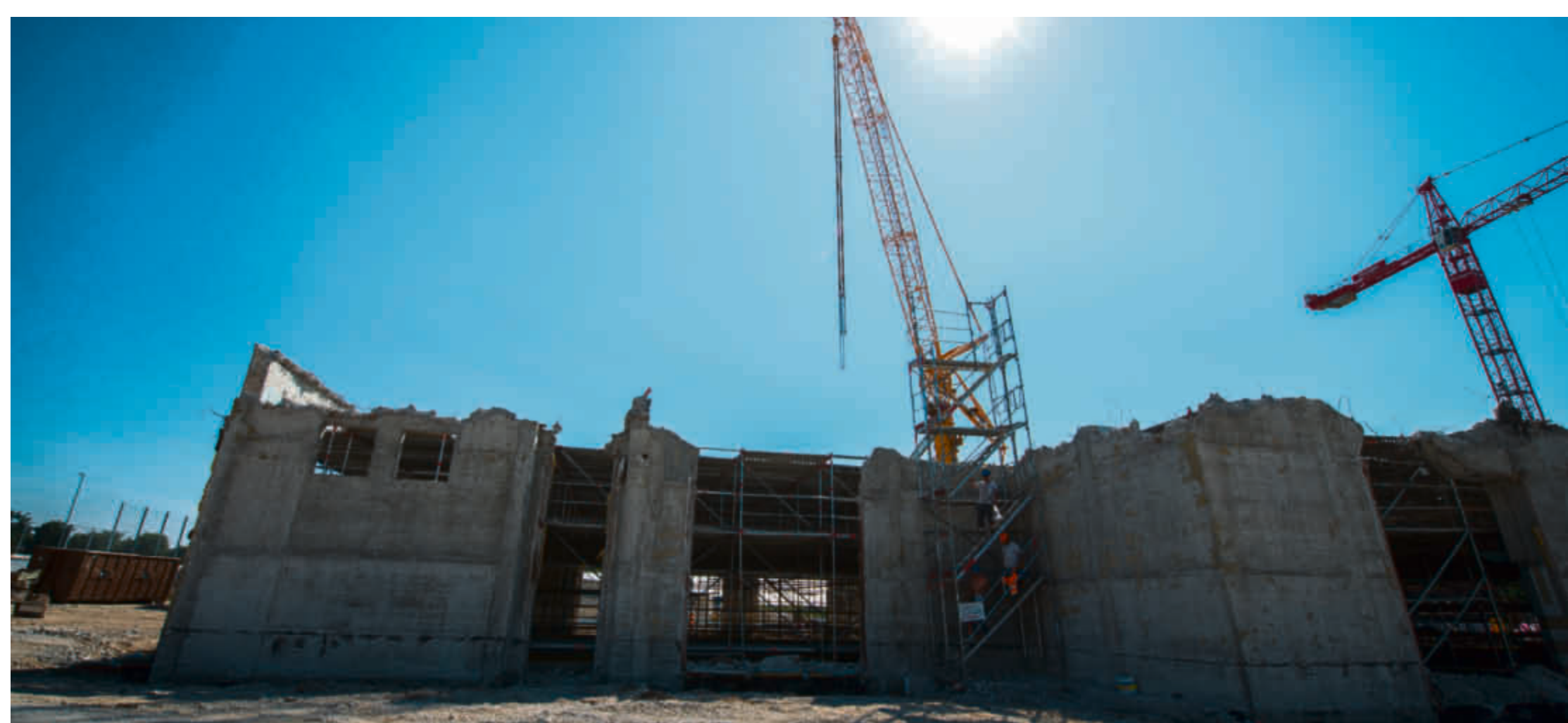
Mit einem Pneukran wurden diese Woche die Betonträger des alten Hallenbads entfernt. Die Wände, die derzeit noch die Fassade bilden, sollen bald komplett abgetragen werden.
