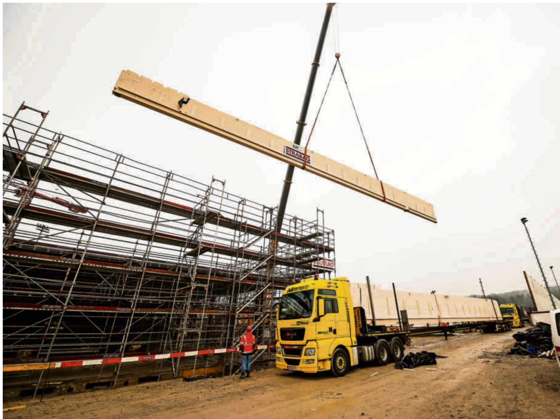
Die Holzträger für das Dach des neuen Hallenbads wurden mit 40 Meter langen Lastwagen von Deutschland nach Uster transportiert.
